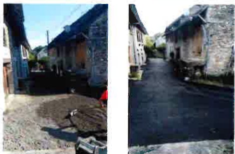
Pendant et après les travaux
