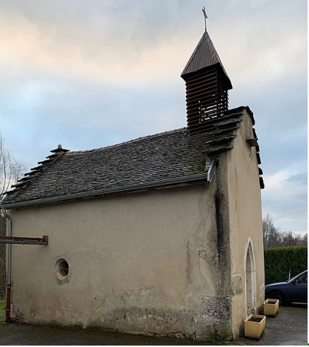
Ci-contre la chapelle de Cressieu avant les premier travaux de rénovation
