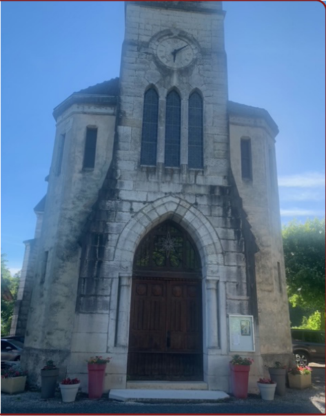
Ci-contre l’église de Chazey-Bons avant les travaux de rénovation et de sécuristation
