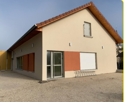
Nouvelle extension du groupe scolaire
