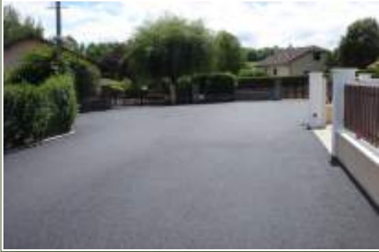
Impasse du Marais (Cressieu) Revêtement d'enrobé
