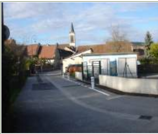
Maison des Associations Pose de balises pour interdire le stationnement à proximité des armoires (fibre)
