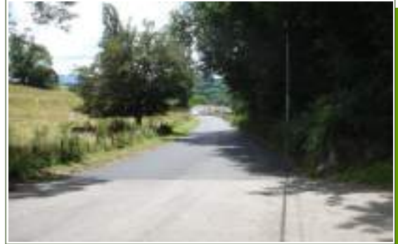
Route de Montchoisi Reprise de la chaussée en enrobé sur 100 m
